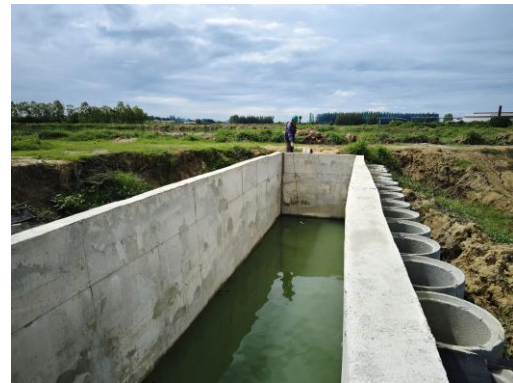
ระบบน้ำเสียชนิดความสกปรกสูง บริเวณถังตรวจสภาพน้ำเสีย (Inspection Pond)
